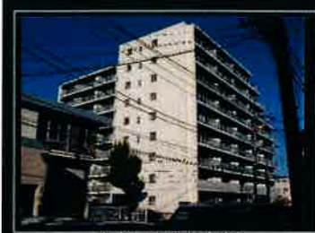
建物西側外観
